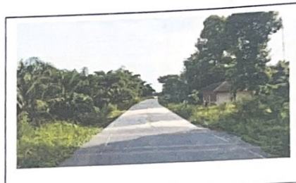
กม. ...๐...+...๐๘๕... (สภาพสายทางโดยทั่วไป)
