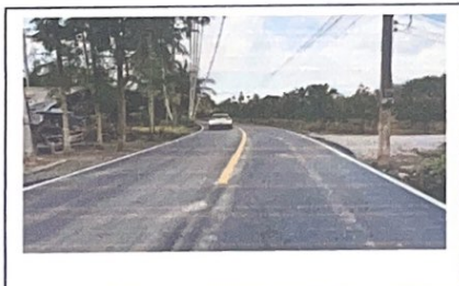
กม. ...๐...+...๙๕๐... (สภาพสายทางโดยทั่วไป)
