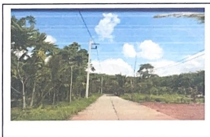
กม. ...๑...+...๓๐๐... (สภาพสายทางโดยทั่วไป)
