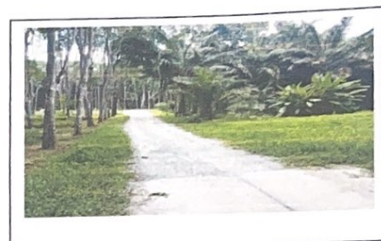
กม. ...๑...+...๑๘๒... (สภาพสายทางโดยทั่วไป)
