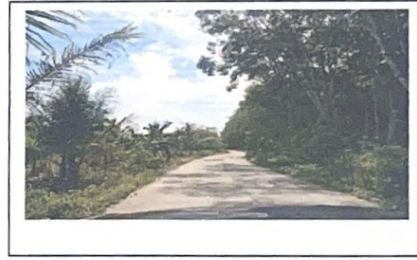
กม. ...๐...+...๒๓๗... (สภาพสายทางโดยทั่วไป)
