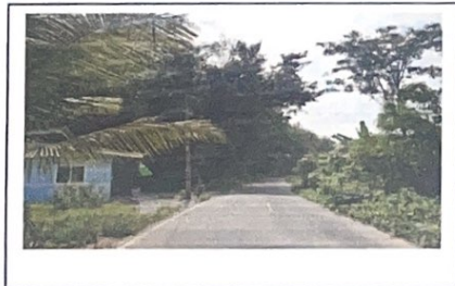
กม. ...๐...+...๗๓๗... (สภาพสายทางโดยทั่วไป)
