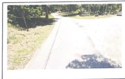
กม. ...๐...+...๙๐๐... (สภาพสายทางโดยทั่วไป)
